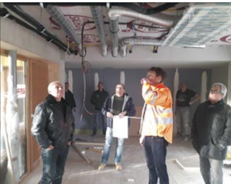
Les plafonds en bois vont être posés prochainement.
